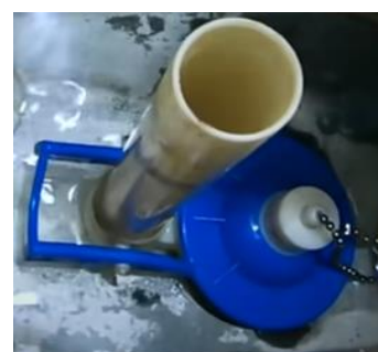
3.安裝止水皮、兩段式沖水把手
