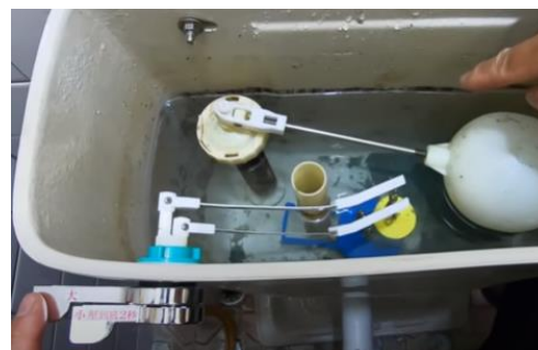
2.拆下扣環、止水皮及沖水把手
