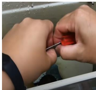
2.拆下扣環、止水皮及沖水把手
