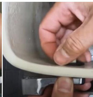
2.拆下扣環、止水皮及沖水把手
