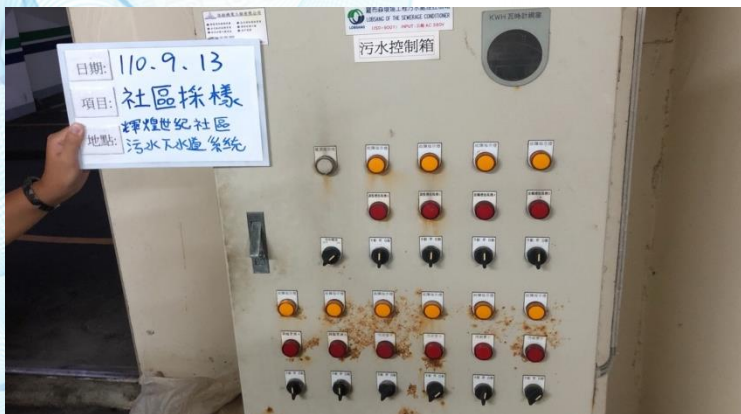
自動控制盤故障而無運作
