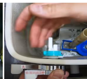
3.安裝止水皮、兩段式沖水把手
