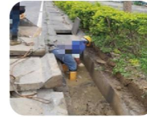
◀ 廢水未經沉砂池或直接将廢水排入側溝，造成排水溝泥沙淤積！
