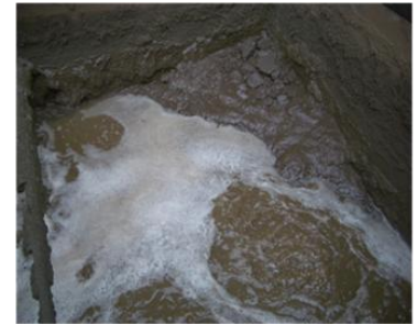
貯槽底部沉積大量污泥
