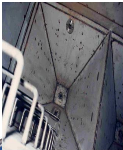
沉澱槽污泥斗
