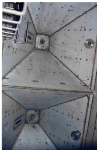
沉澱槽污泥斗
