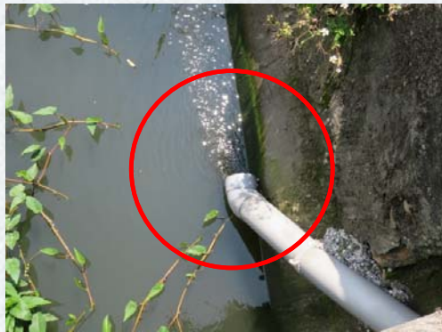
❌ 放流口接觸地面水體， 無法採集具代表性水樣
