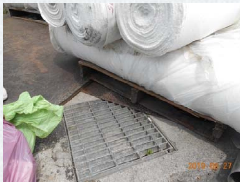
❌ 放流口堆放雜物
