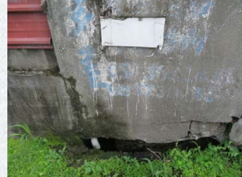
❌ 告示牌內容字跡脫落
