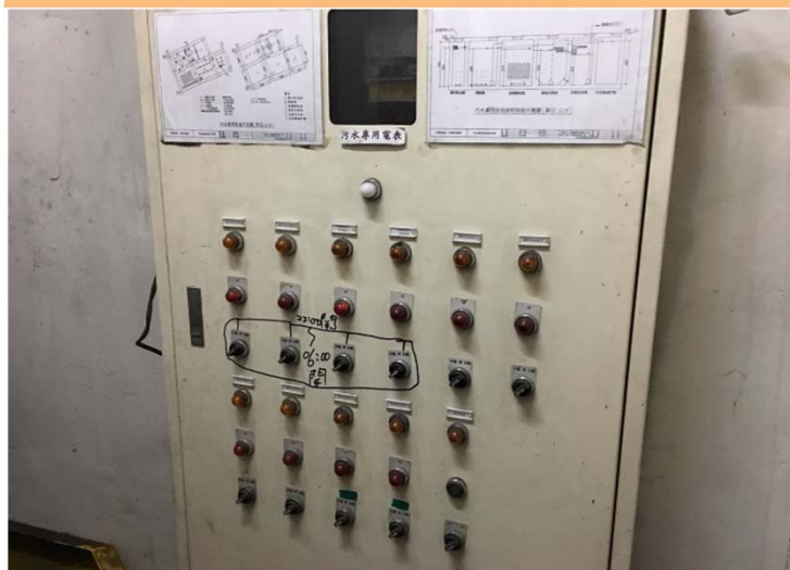
自動控制盤故障而無運作
