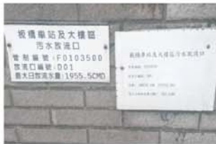
放流口告示牌
