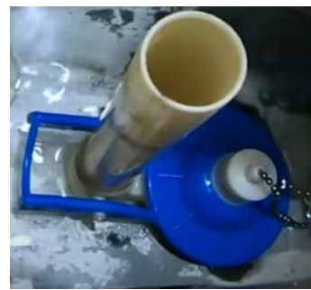
3. 安裝止水皮、兩段式沖水把手
