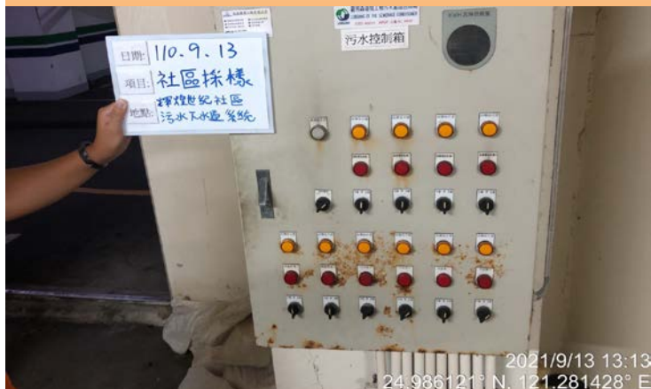
自動控制盤故障而無運作
