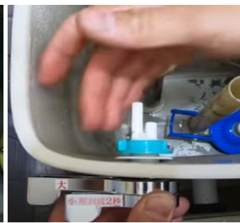
3. 安裝止水皮、兩段式沖水把手
