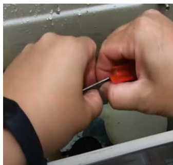
2. 拆下扣環、止水皮及沖水把手
