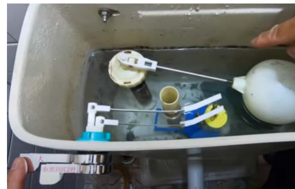
3. 安裝止水皮、兩段式沖水把手
