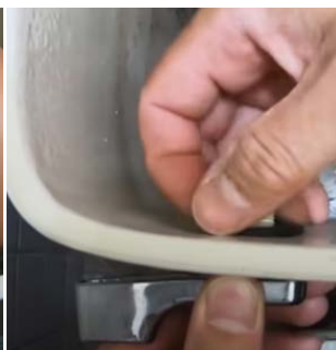
2. 拆下扣環、止水皮及沖水把手
