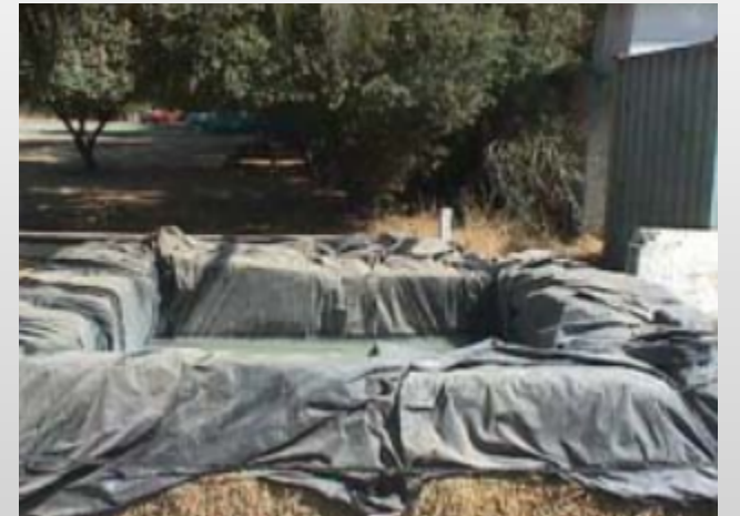
於工地設置之 混凝土拌和車 臨時清洗場
