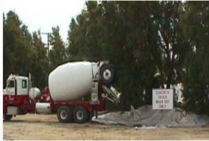
於工地設置之 混凝土拌和車 臨時清洗場
