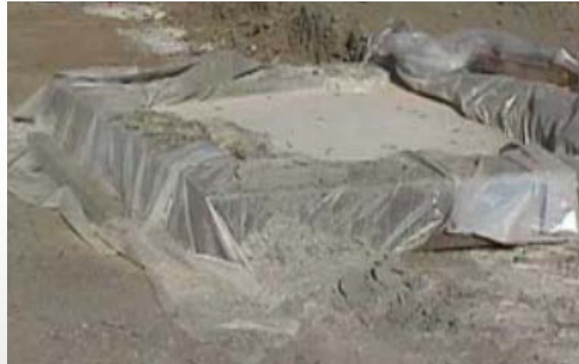
混凝土漿液未適時 清理之污染
