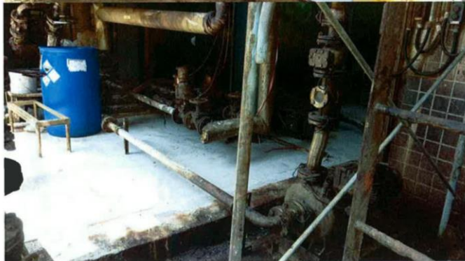
圖 5-5 L 棟廠房舖面重新建置(1/2)
