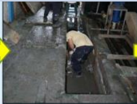
污泥挖除(有害廢棄物)
