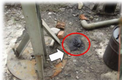
油品滴落且地表鋪面破碎
