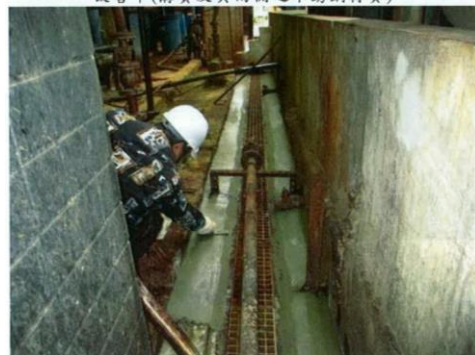
改善中(導水溝底及兩側材質更換)
