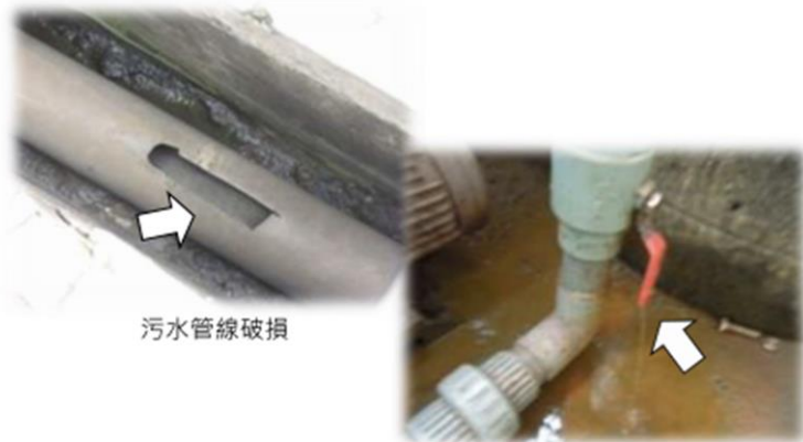
污水管線閘門接頭漏水
