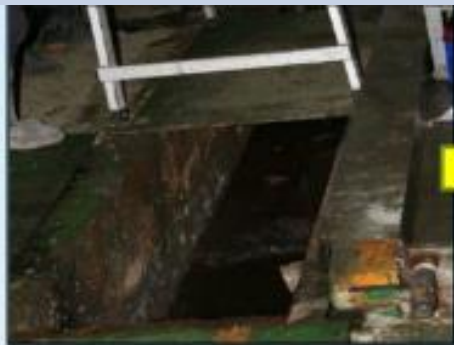
原磚造排水溝
