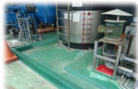
廢水儲槽區設防溢堤 地表塗佈環氧樹脂(EPOXY)
