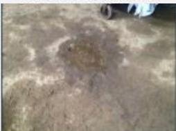
酸液滴落腐蝕地表
