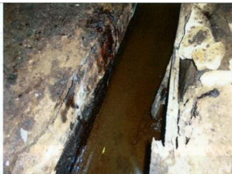
改善前(導水溝以水泥建構)
