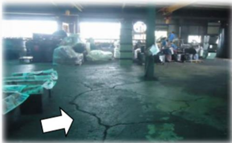
地表鋪面破損
