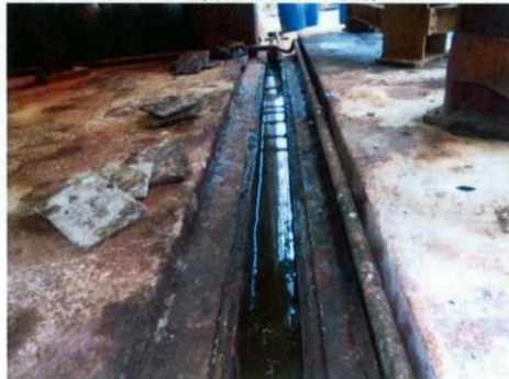
改善前(導水溝以水泥建構)
