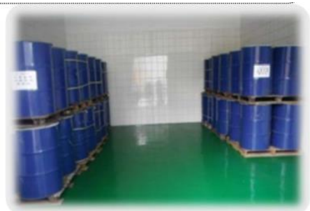
地表塗佈環氧樹脂(EPOXY)
