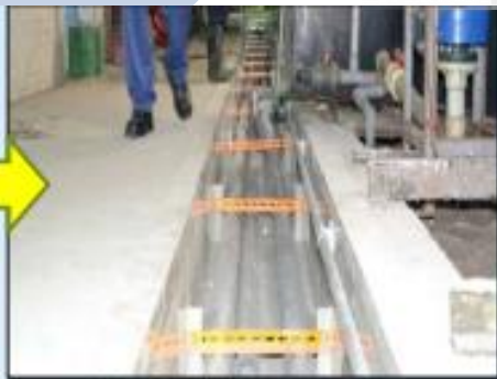
抗腐蝕材質重建
