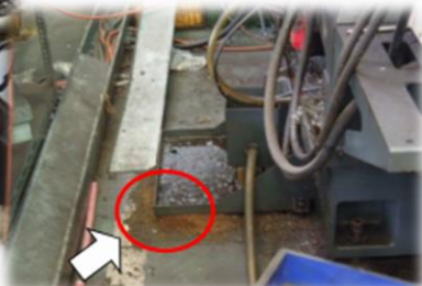
製程機具下方雖已設置盛油盆 機具之潤滑油品仍溢流至地面
