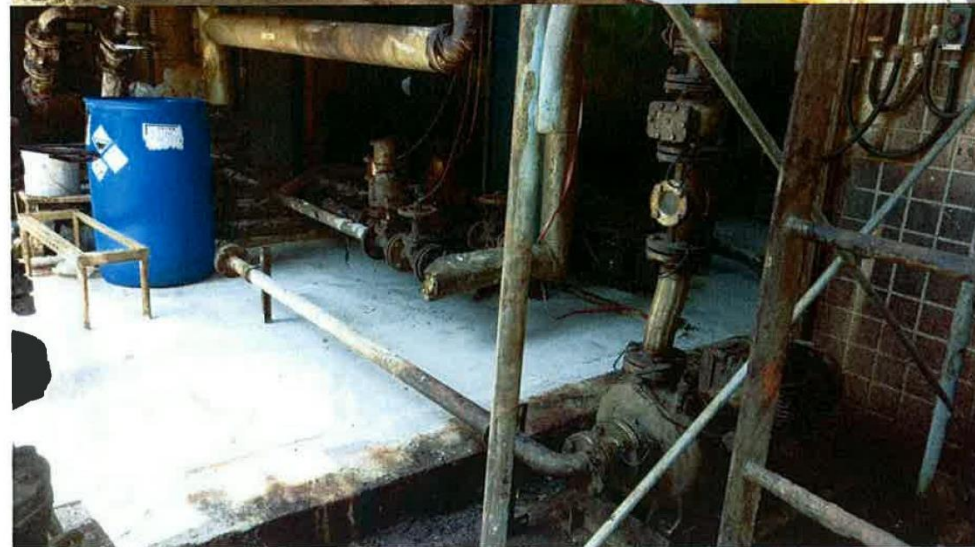
圖 5-5 L 棟廠房鋪面重新建置(1/2)
