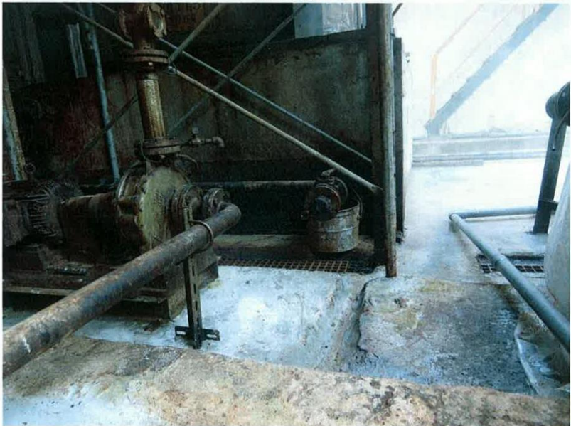
圖 5-5 L 棟廠房鋪面重新建置(2/2)
