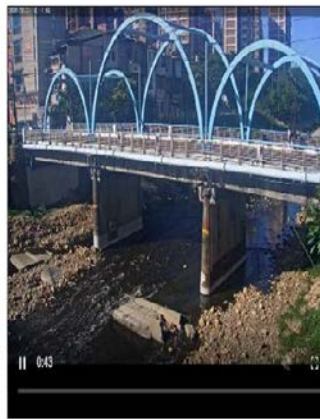
龜山橋 CCTV 影像
