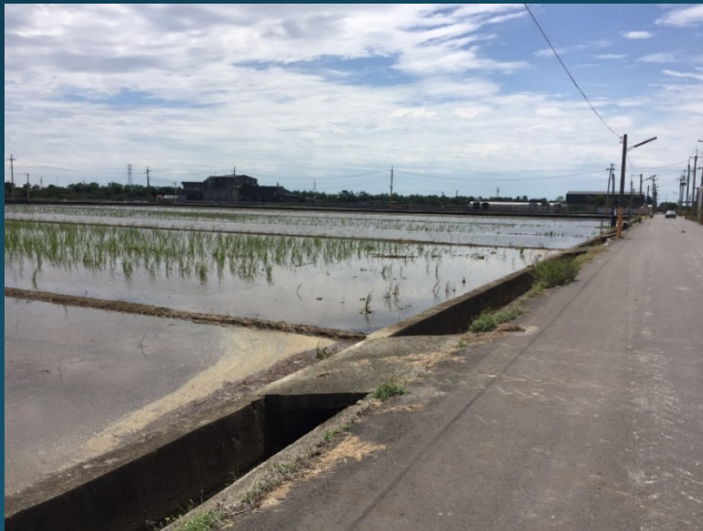
常見的水泥化田間溝渠
