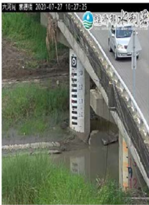
崇德橋 CCTV 影像
