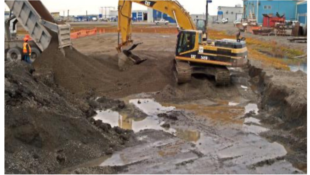
回填作業之逕流廢水源
