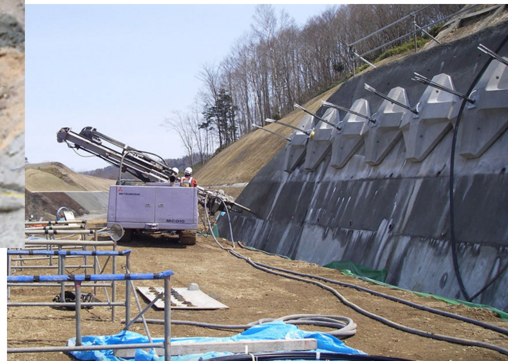
地錨施工(鑽孔及灌漿)作業廢水
