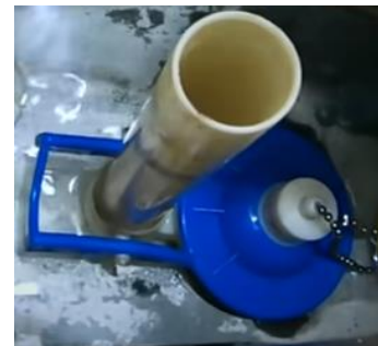
3. 安裝止水皮、兩段式沖水把手
