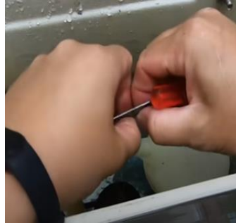
2. 拆下扣環、止水皮及沖水把手
