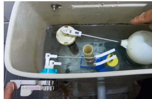
2. 拆下扣環、止水皮及沖水把手
