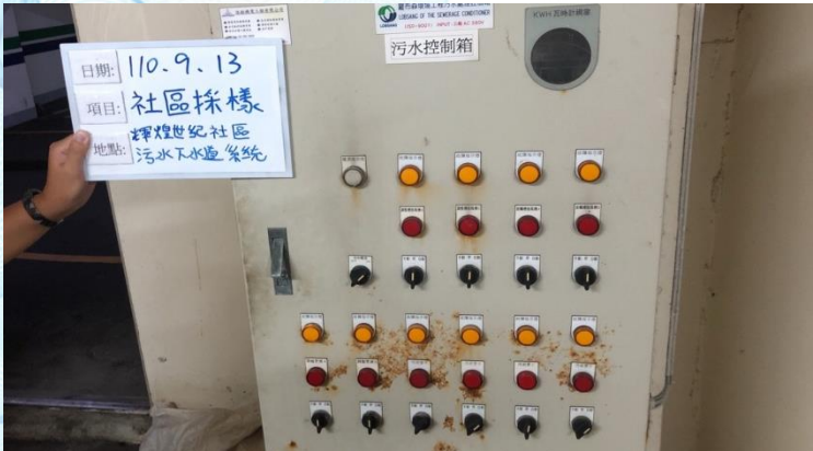
自動控制盤故障而無運作
