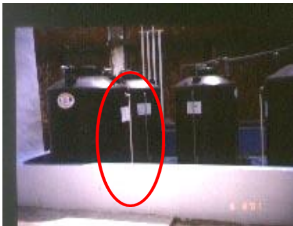
化學藥劑槽外設置液位觀測計
