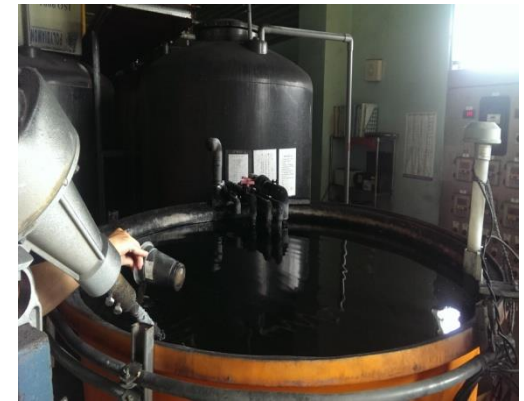
脫脂廢液使用活性炭 吸附前處理
