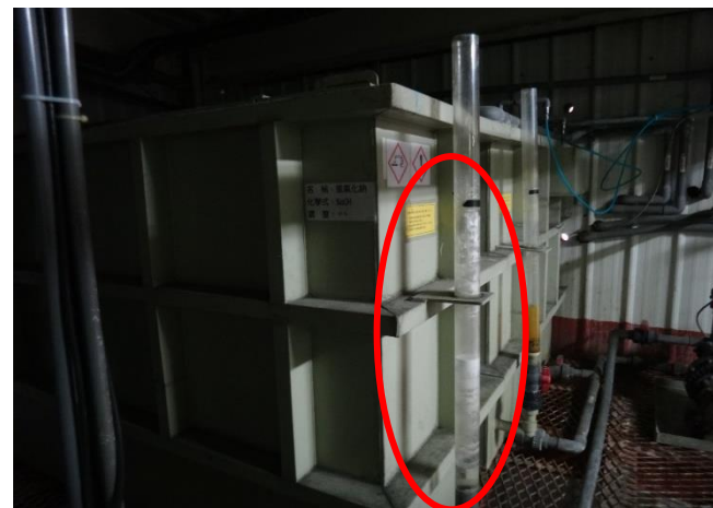
化學藥劑槽外設置液位觀測計
