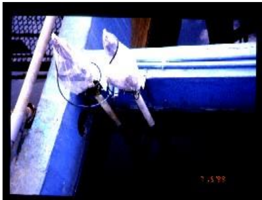
pH監測計、ORP監測計 設置於反應槽出流端
