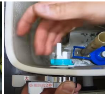
3. 安裝止水皮、兩段式沖水把手
