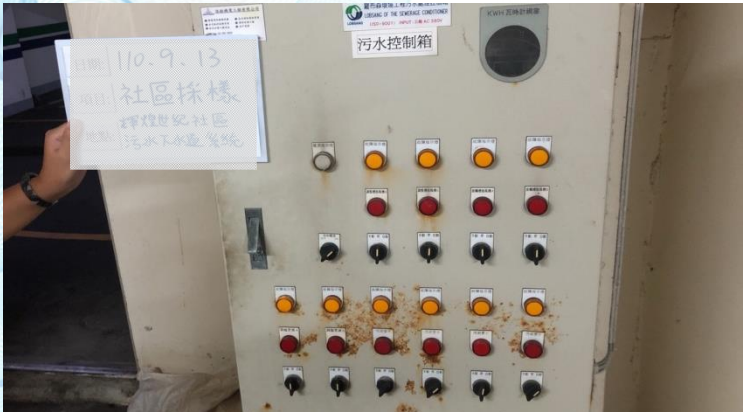
自動控制盤故障而無運作
