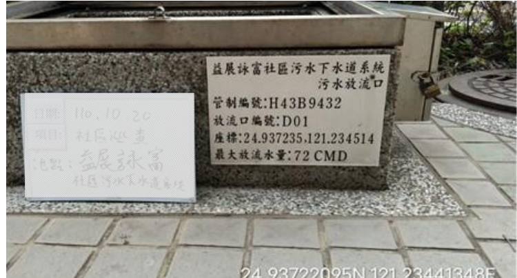
標示放流口告示牌
