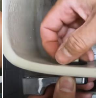
2. 拆下扣環、止水皮及沖水把手
