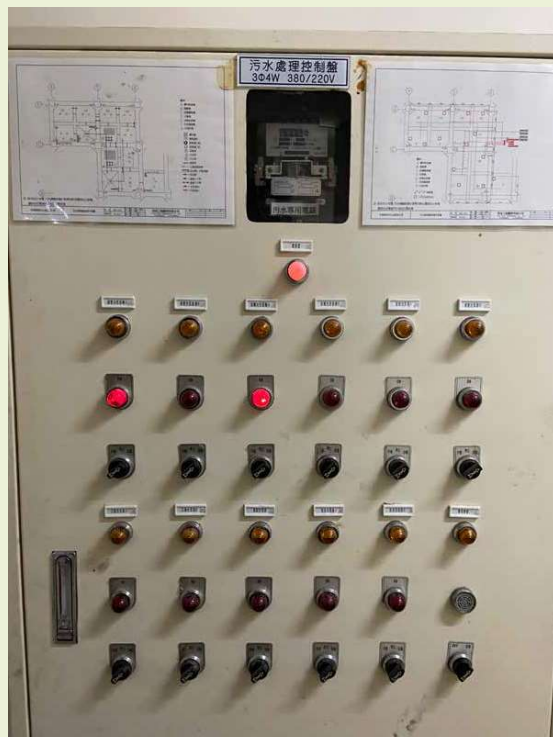
圖4 污水控制盤
