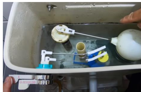
2. 拆下扣環、止水皮及沖水把手
