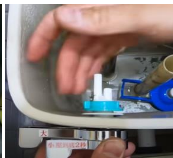
3. 安裝止水皮、兩段式沖水把手
