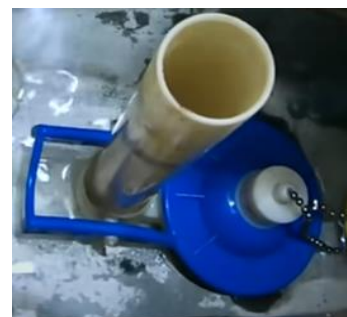
3. 安裝止水皮、兩段式沖水把手
