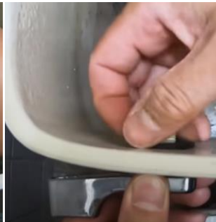
2. 拆下扣環、止水皮及沖水把手
