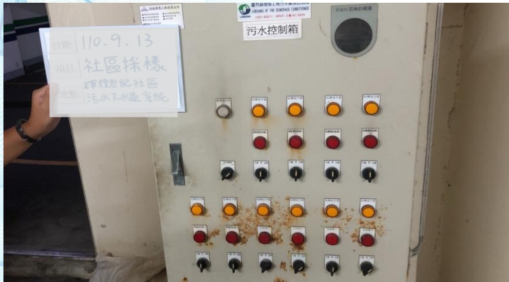
自動控制盤故障而無運作
