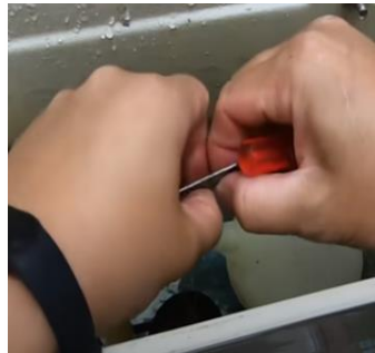
2. 拆下扣環、止水皮及沖水把手
