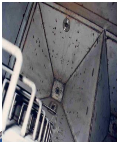
沉澱槽污泥斗
