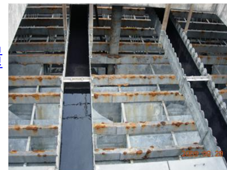
沉澱池增設傾斜板
