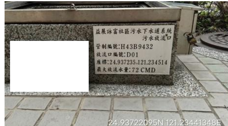
標示放流口告示牌
