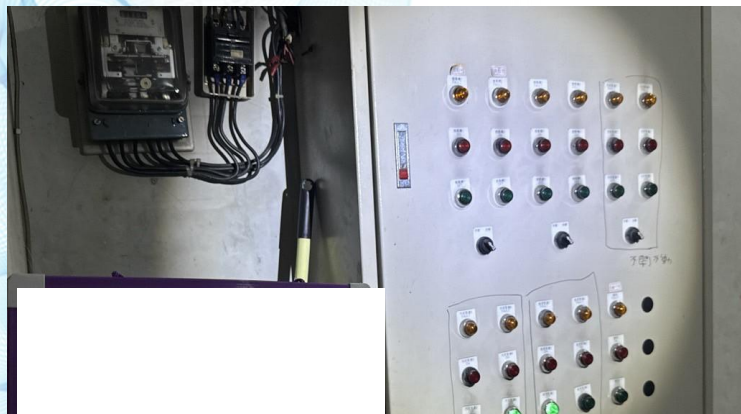
自動控制盤故障而無運作
